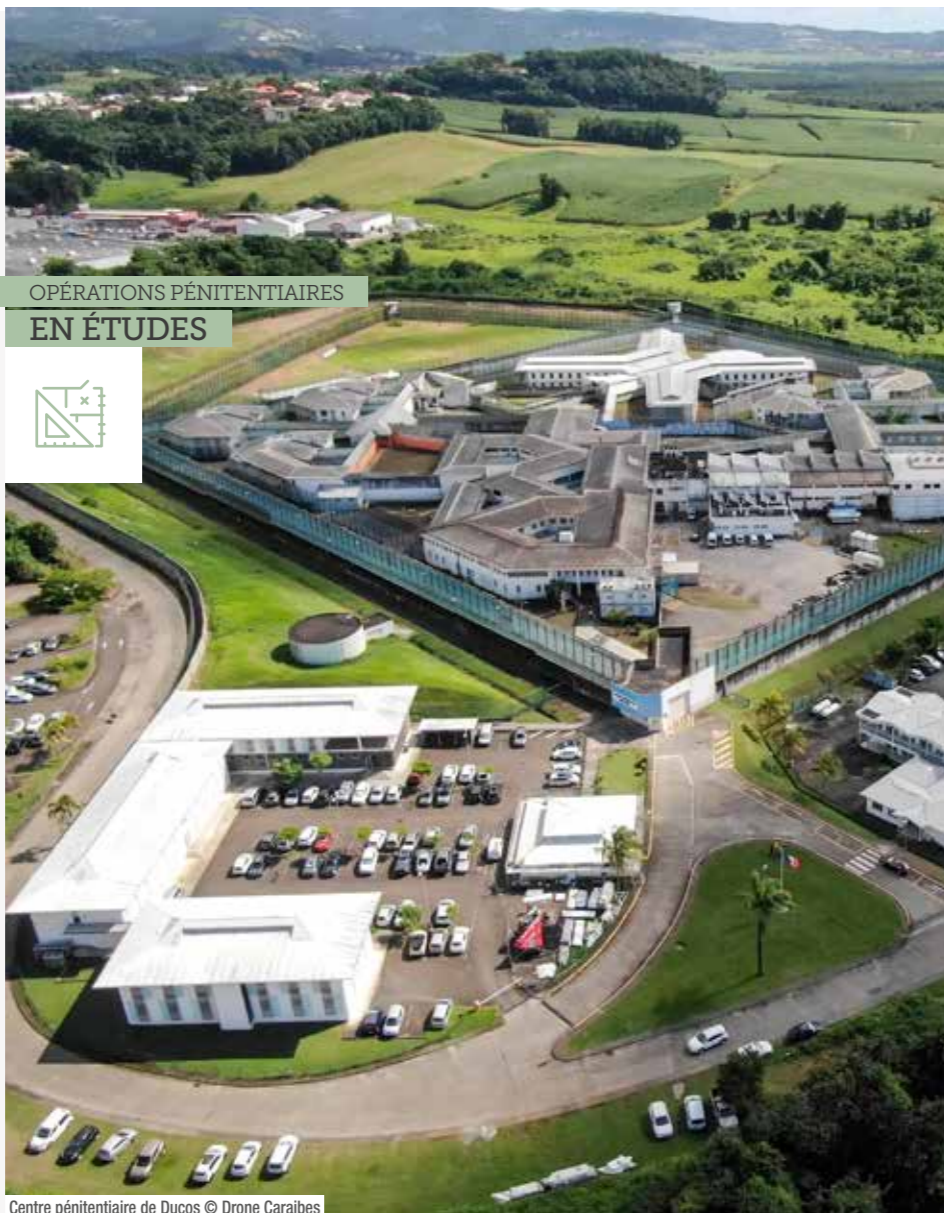
Centre pénitentiaire de Ducos © Drone Caraïbes
