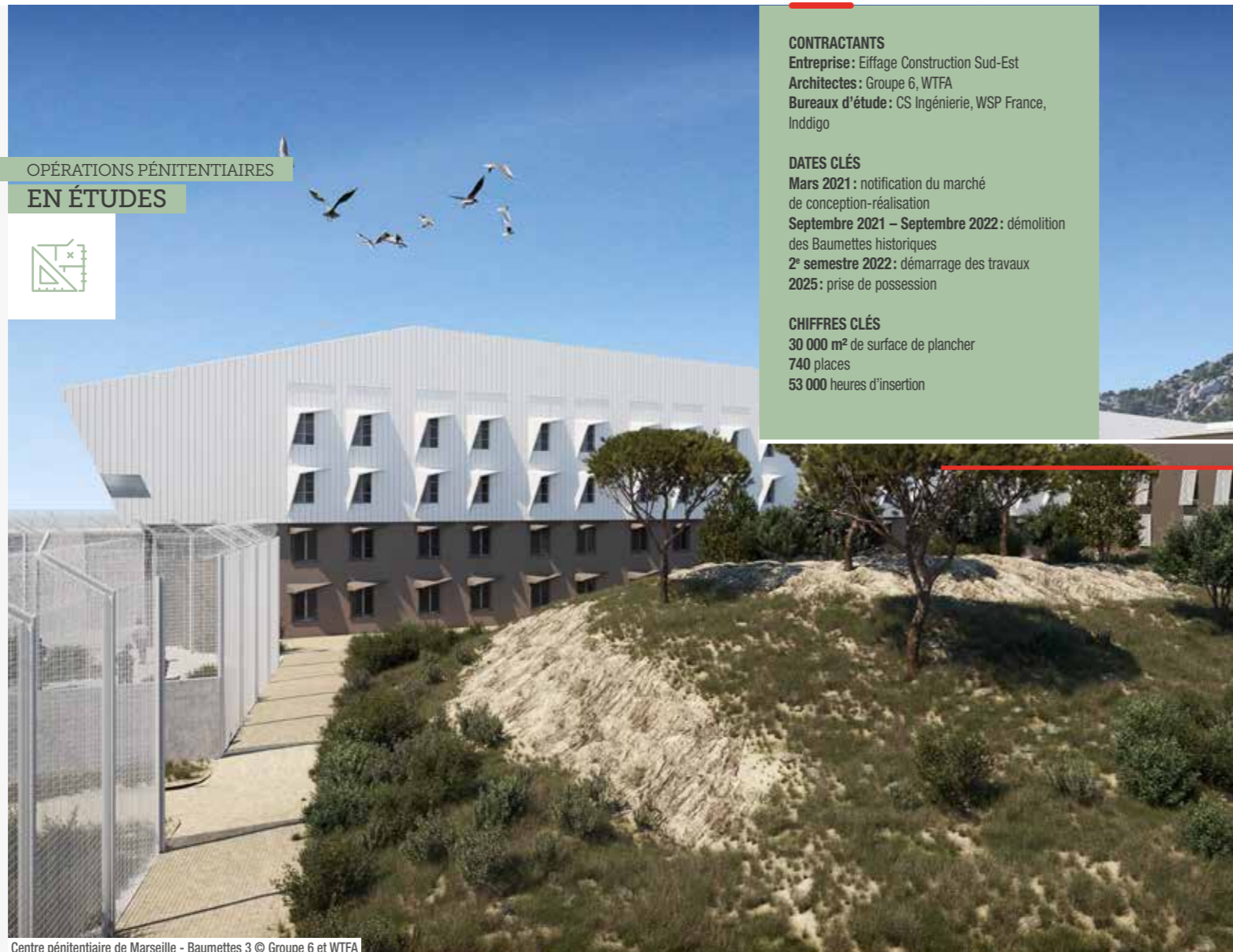
Centre pénitentiaire de Marseille - Baumettes 3 © Groupe 6 et WTFA
