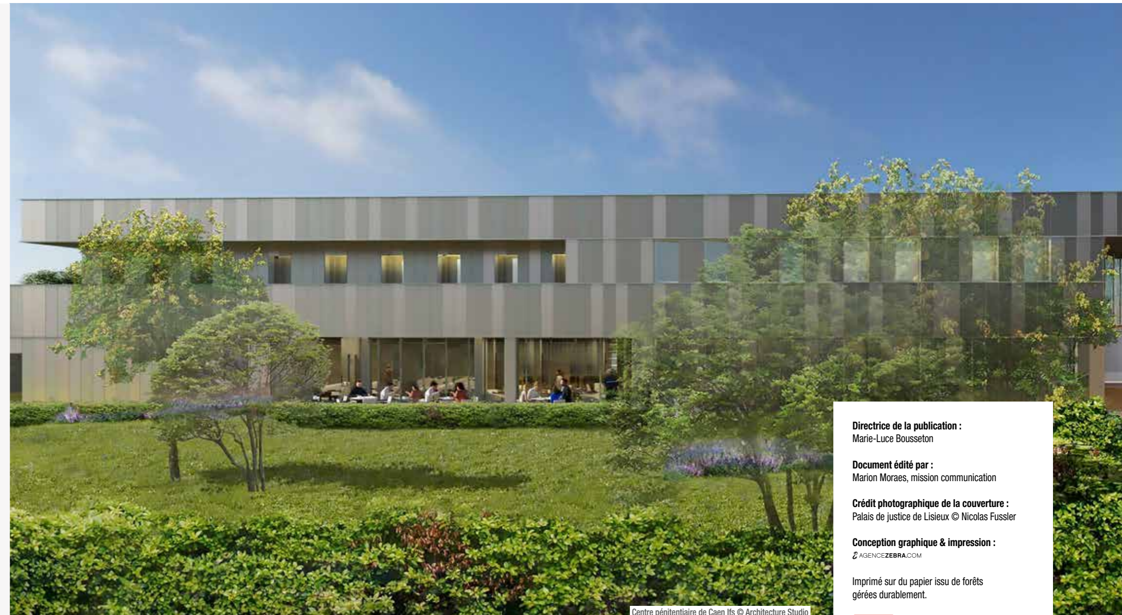
Centre pénitentiaire de Caen Ifs © Architecture Studio
